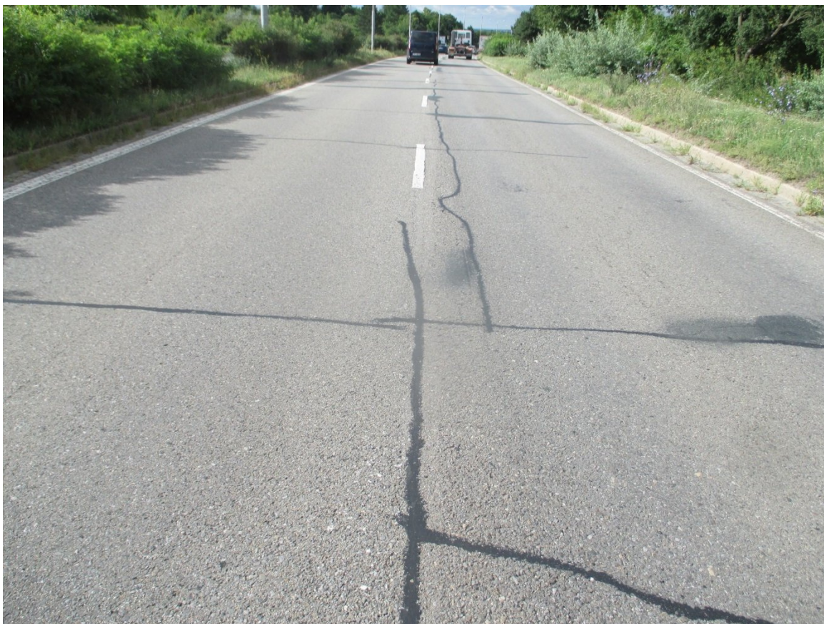
F11, km 54,210+ PP Příčné a podélné trhliny, vysprávký tryskovou metodou, nepravidelné hrboly.
