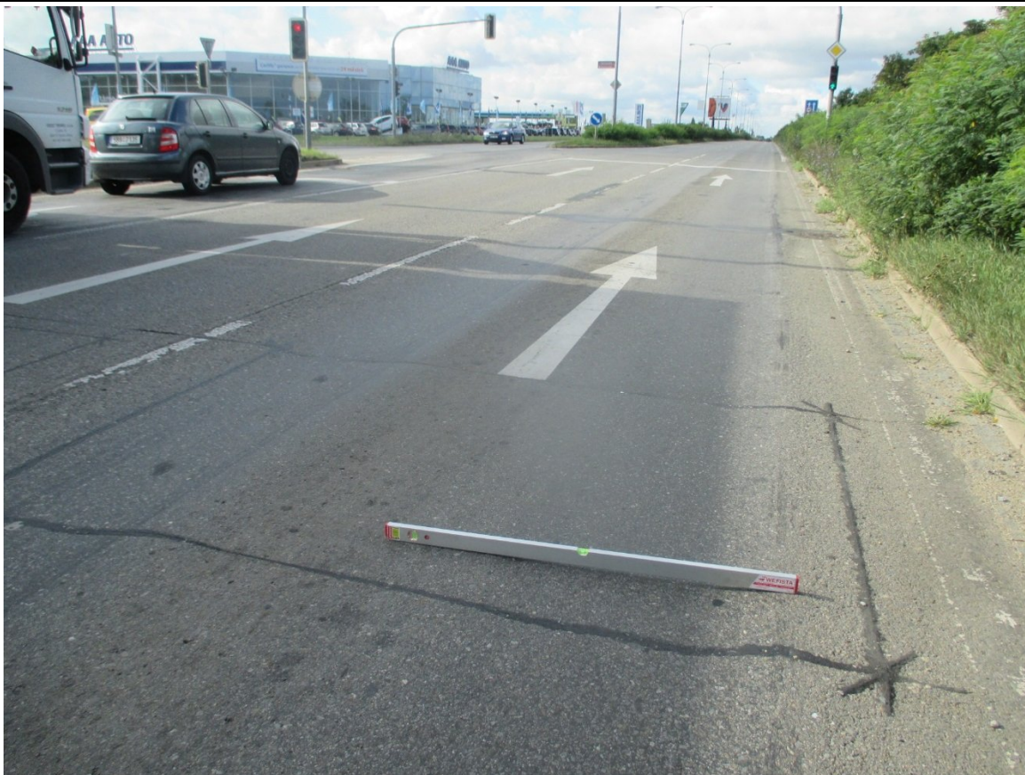
F03, km 53,410+ PP Vyjeté koleje před křižovatkou.
